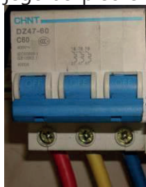
Rysunek 9 Przykładowe zabezpieczenie nadprądowe
